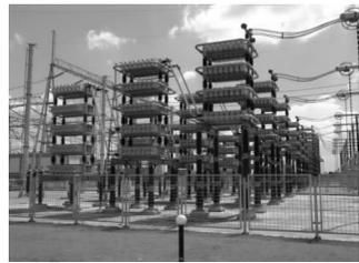
图7 66 kV 电容器组实地安装图
