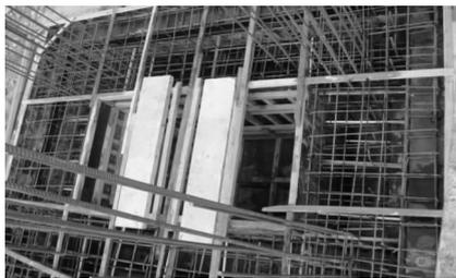
图 1 暗圈梁配筋绑扎图
